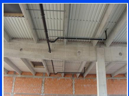
Podtlačni odvodnjavanje meteorne vode sistem »siaqua«
